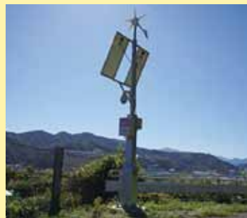
藤沢市川名に設置された「AI映像河川水位監視システム」(試験中)。
